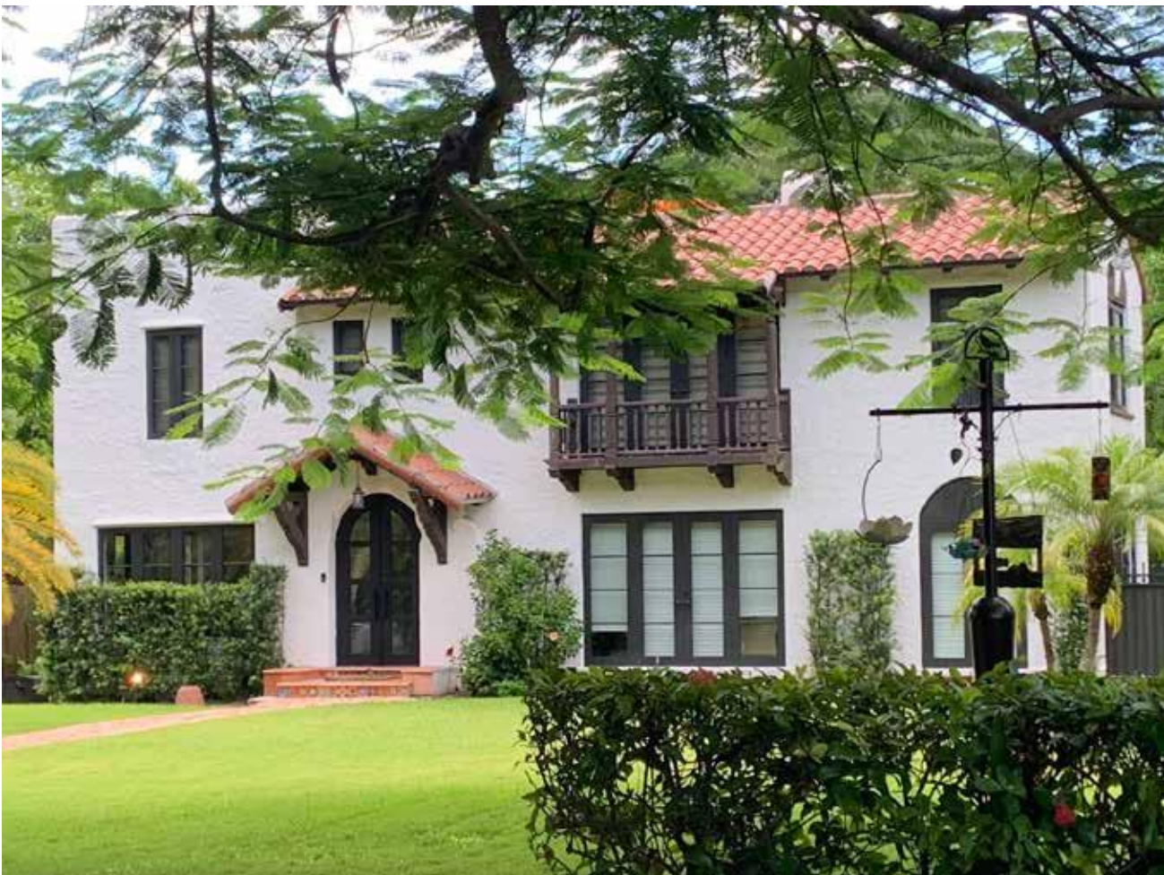
Front façade (Kolaya)
